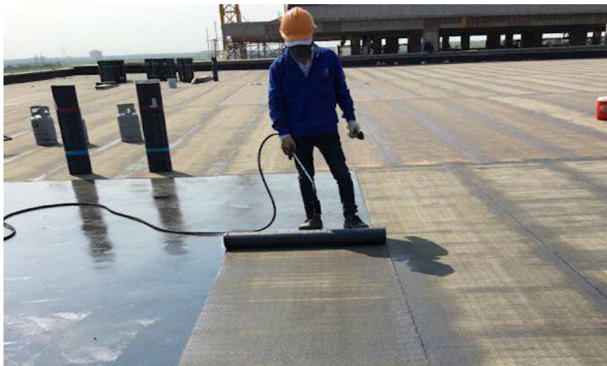
CHỐNG THẤM BẰNG MÀNG KHÒ GỐC BITUME
