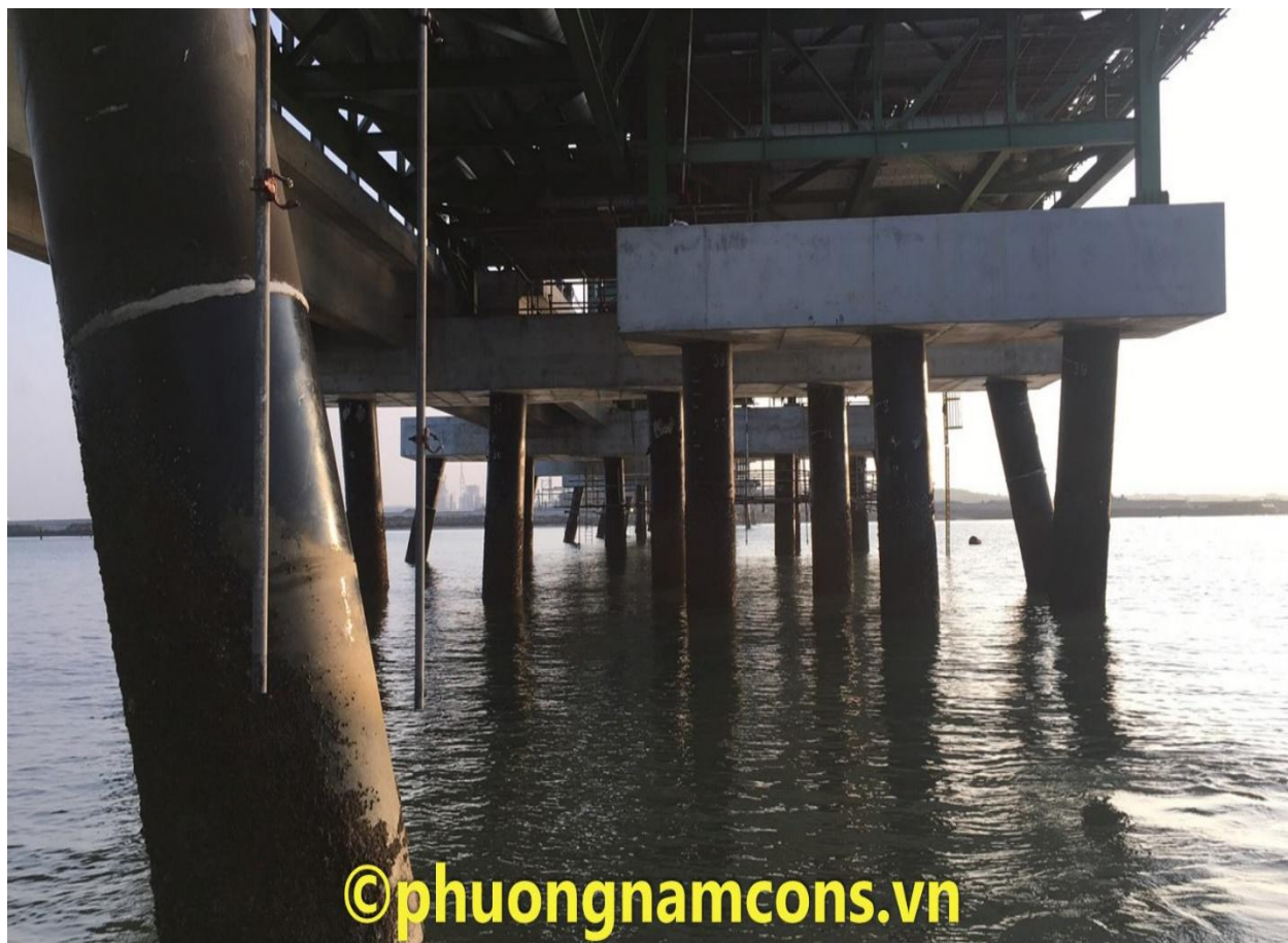
SỬA CHỮA CỌC THÉP CẢNG HJ- LONG SƠN PETRO CHEMICAL PROJECT
