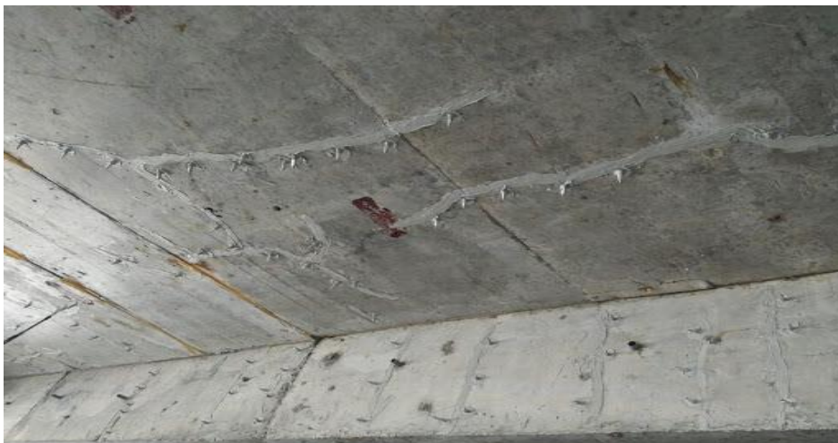
XỬ LÝ NÚT BÊ TÔNG SÀN
