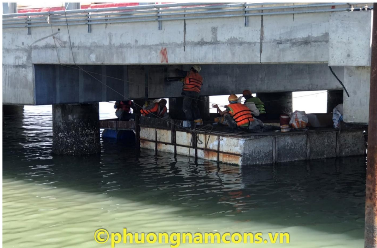
GIA CỐ KẾT CẤU CẢNG CJ- LONG SƠN PROJECT
