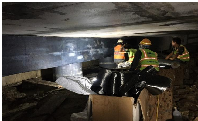
THI CÔNG CHỐNG ĂN MÒN CẦU CẢNG
