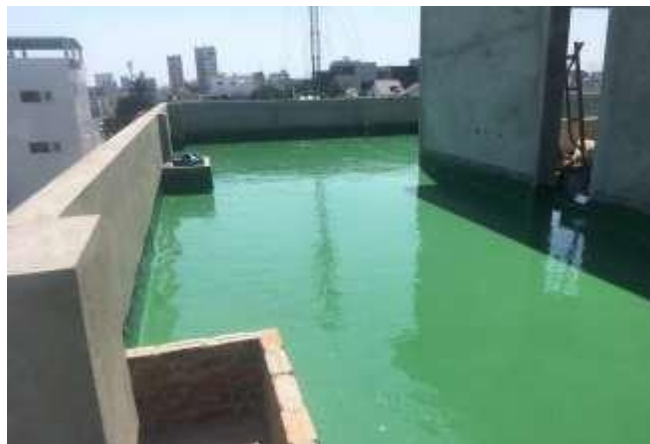
CHỐNG THẤM KHE CO GIỖN CHỐNG THẤM SÀN MÁI BẰNG VẬT LIỆU PU
