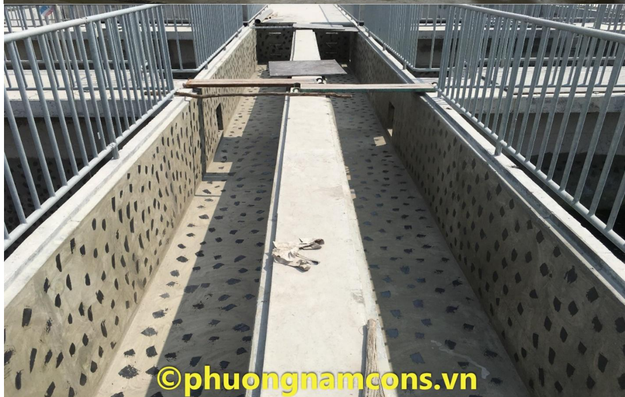
CHỐNG THẤM NHÀ MÁY XỬ LÝ NƯỚC THẢI BÌNH HƯNG – WWTP
