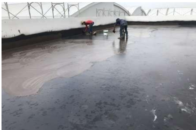
CHỐNG THẤM BITUME GỐC NƯỚC
