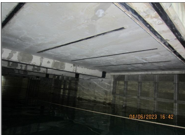
GIA CỐ KẾT CẤU THÁP GIẢI NHIỆT NHÀ MÁY LỘC DẦU LONG SƠN
