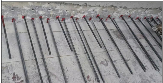
KHOAN CÂY THÉP NHÀ ĐIỀU HÀNH CẢNG HIDRO CARBON - LỘC HOÁ DẦU LONG SƠN
