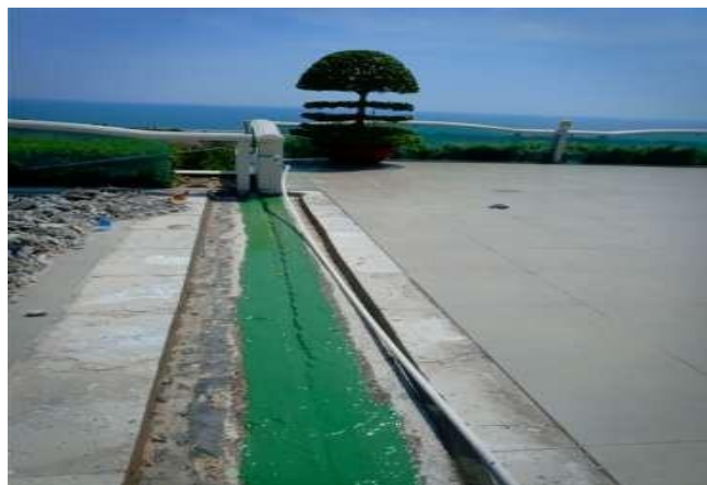
CHỐNG THẤM KHE CO GIỖN CHỐNG THẤM SÀN MÁI BẰNG VẬT LIỆU PU
