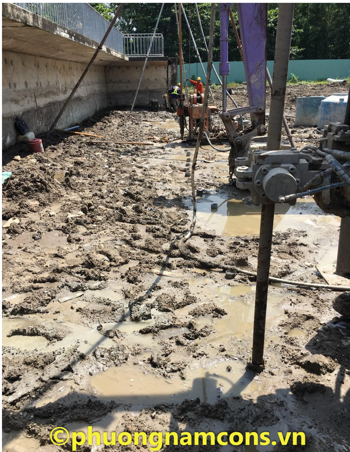
JET GROUTING - BÊ LĂNG
