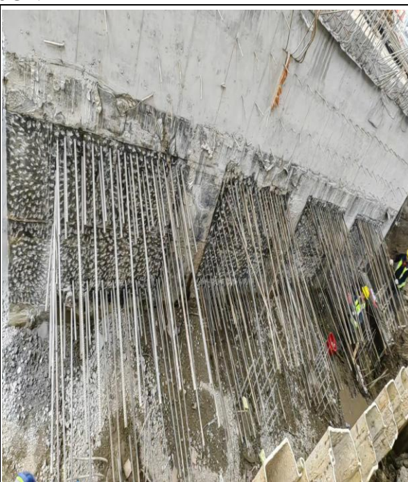
KHOAN CÂY THÉP BỂ LÀM MÁT- GÓI A1- LỘC HOÁ DẦU LONG SƠN
